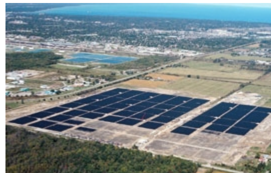
Станция в г. Сарниа (Sarnia, Канада)
