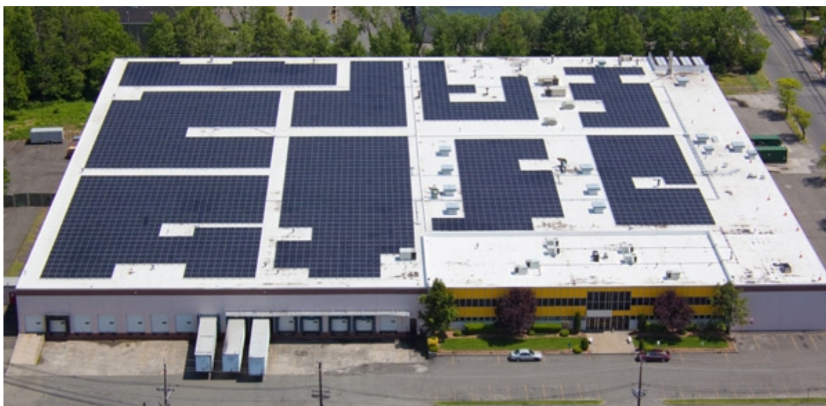
Крупнейшая инсталляция панелей Solyndra в США, завершенная в июне 2010 года. Объект инсталляции - завод LPS Industries во Фремонте (Калифорния); число модулей - 3800 шт.; мощность - 704 кВт (источник: Solyndra)
